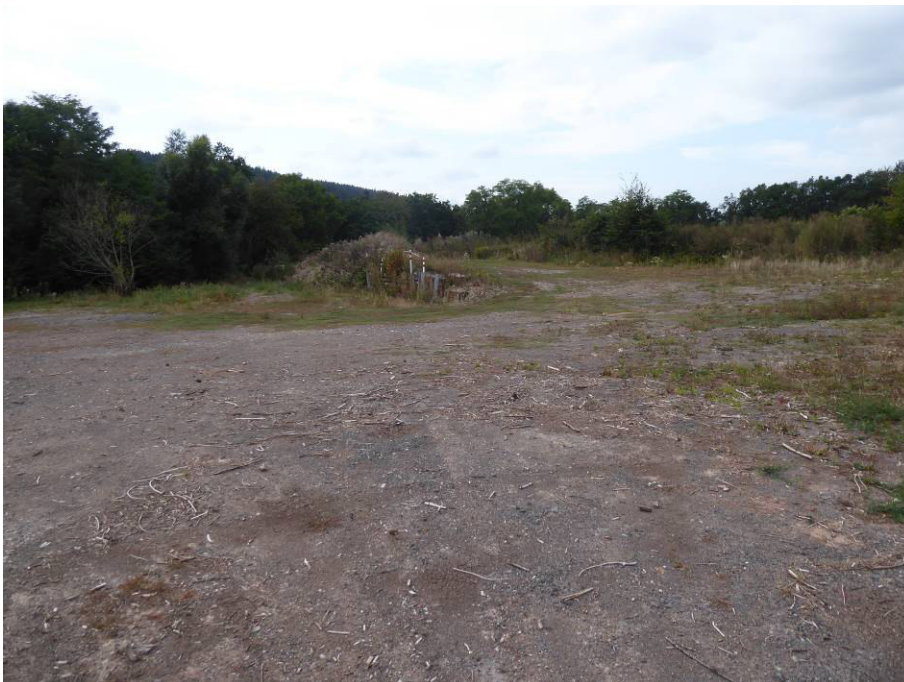
Abb. 7: Befestigte Lagerfläche mit ehemaliger Rampe
