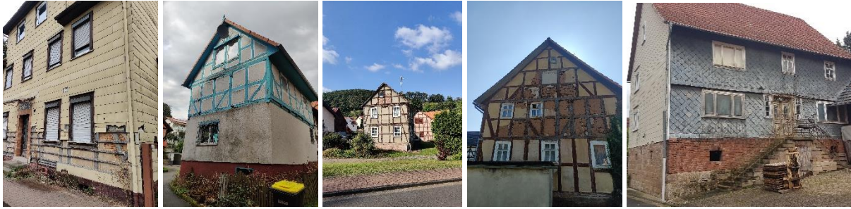
Abbildung 51: Sanierungsbedarfe von Fassaden in den Stadtteilen (Fotos: akp_)
